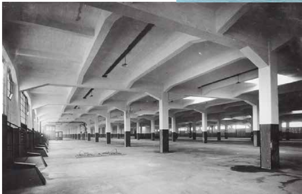
De Fenixloods: een binnenzicht. Foto Stadsarchief Rotterdam
